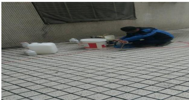
3 淹灌工法的液態材料密度約1.1 g/cm<sup>3</sup>，可自動重力垂流封堵裂縫。
