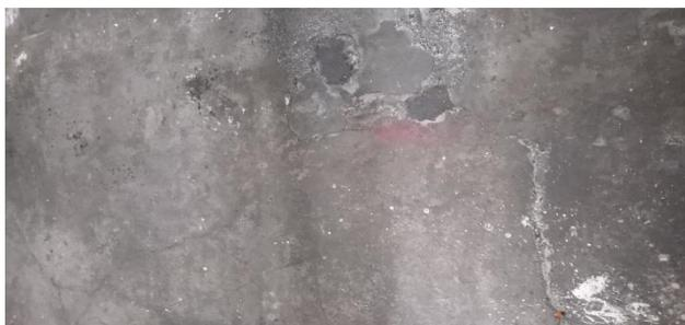
5 淹灌工法可選擇性局部施工，由於流動性佳，更能有效止漏！
