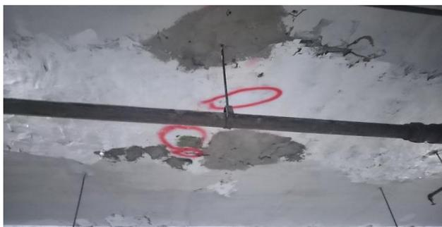
4 淹灌工法的液態材料大約3小時即可固化，不需打除原本地面磁磚，不需乾燥環境即可施工，簡單有效！
