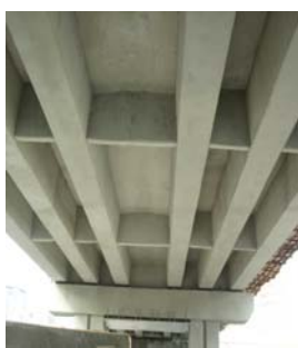
混凝土中 性化處理
