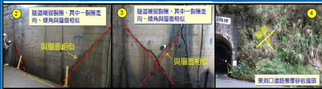
圖 2-1-6 橫嶺山隧道現況地質調查
